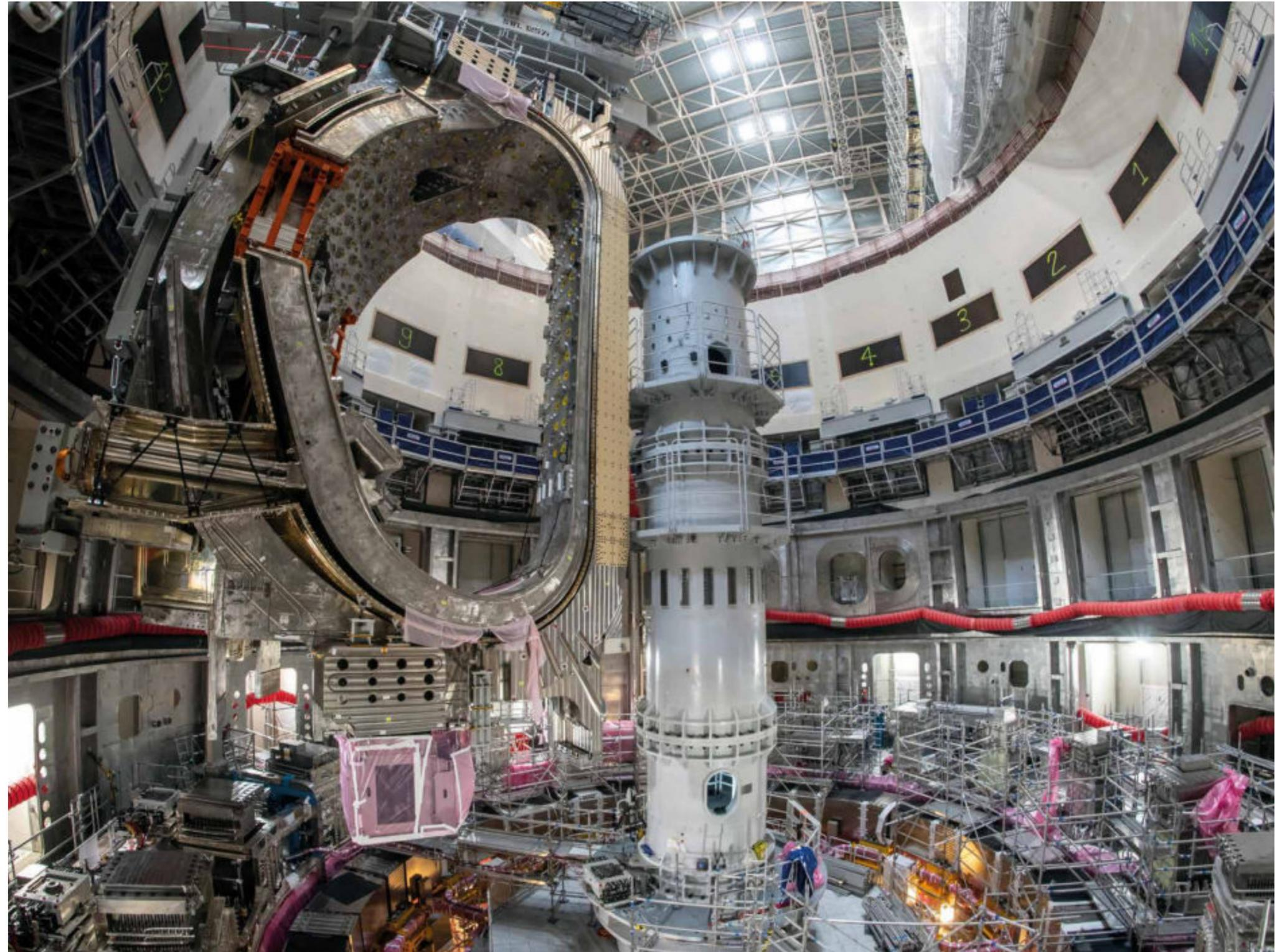
Immagini relative al posizionamento del primo settore della Camera a Vuoto del progetto a Fusione ITER. / Images showing the positioning of the first sector of the Vacuum Chamber of the ITER Fusion project.
